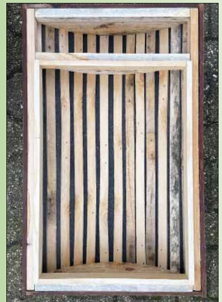
De binnenkant van het dak met voldoende ruimte om door vocht uit te kunnen zetten.
