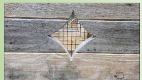
Ventilatiegaten met gaas.
